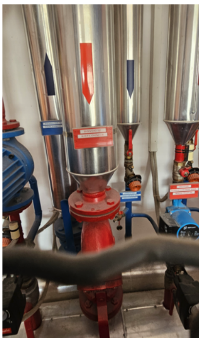
Slika 14: Dovod toplote v telovadnico
